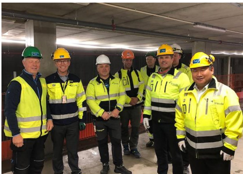
Tore Bakke var sammen med regiondirektør for Sør/Vest, Ronny Øvrevik, på befaring på «Paradis» i Bergen, et prosjekt med boliger og næring hvor Bravida leverer rør, elektro og ventilasjon. Foto: Bravida
